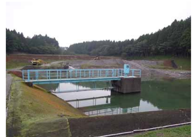
内部貯留の例(台風直後)
