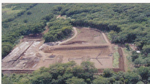
福岡方式に改善中の埋立場 (2003年)
