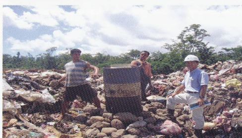
現地の技術者にガス抜管設置を指導 (2004年)
