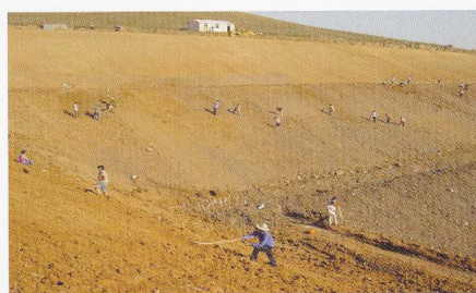
遮水シート施工前の法面の整形 (2002年)
