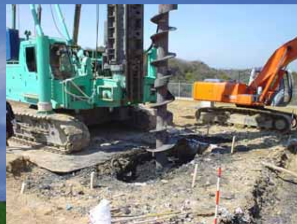
スクリーオーガによる掘削
