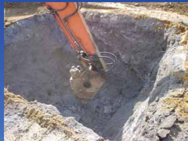
ジャイアントブレイカー掘削
