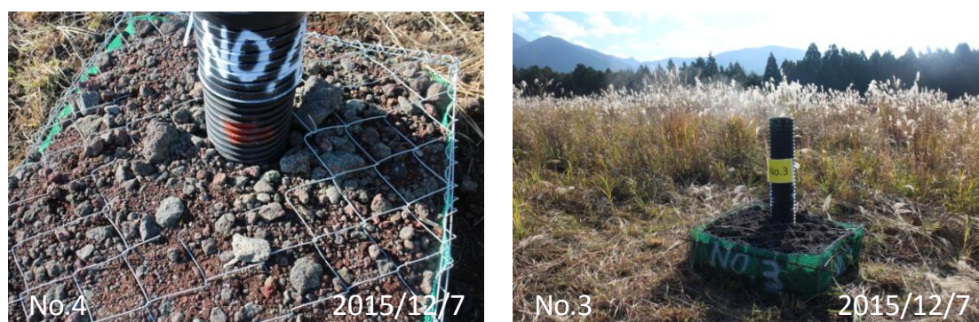
図 4.9 ガス抜き管の出口状況
