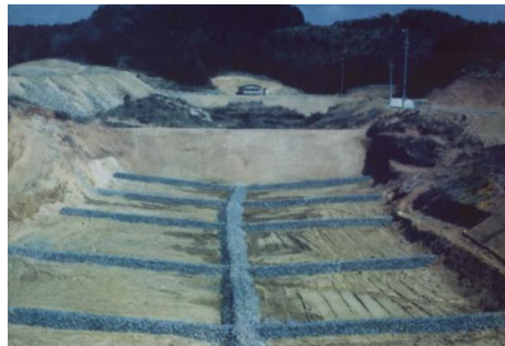
図 5.2 日本初の準好気性埋立構造（新蒲田埋立場） 1)
