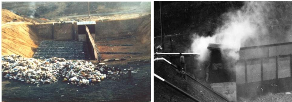
図 5.1 久山埋立場における現場実験 1)
