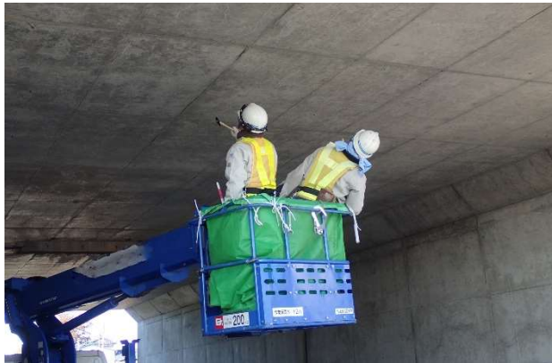
ボックスカルバートの点検 Inspection of box culvert
