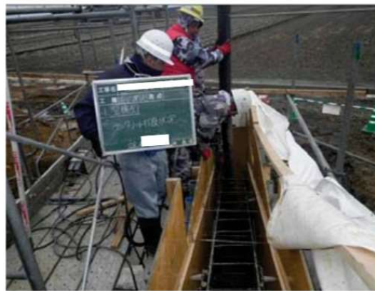
打込み高さを管理 Casting height
