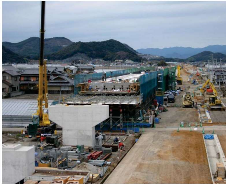
プレストレス中空床版の施工にて In the process of casting of PC hollow slabs
