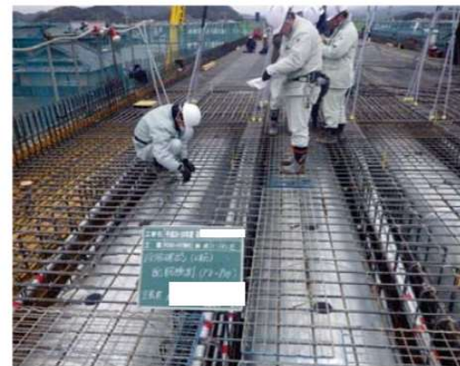
上部鉄筋 Upper reinforcement
