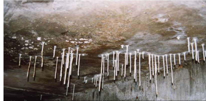
コンクリートの石灰分の析出 Deposition of lime in concrete
