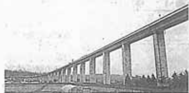
④長流川(おさるがわ)橋 伊達市を横切る道央自動車道(上下線共有)の自動車専用橋。河川を渡る高速道路の橋で国内最長の1772.5m。1984年供用開始。
