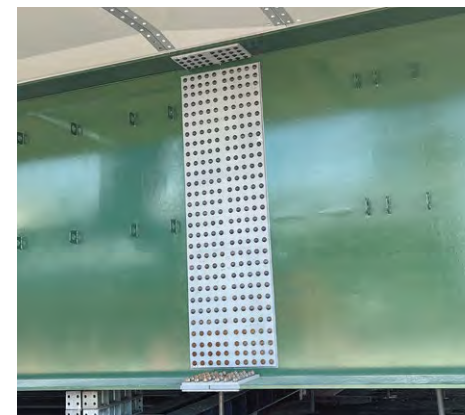
▲(図1) 鋼道路橋のボルト連結
