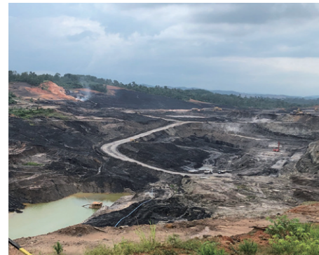
▲表層の土砂を発破と鉱山機械で剥ぎ取り、その下にある石炭層を掘り起こします。
