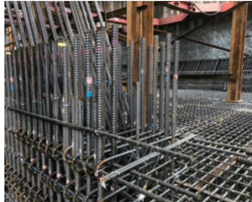
▲BIM/CIMモデルにより設計図からの修正を反映した現場の実配筋
