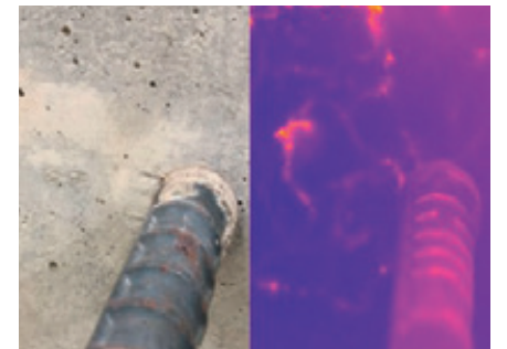
Sonic-IRによるコンクリート中のひび割れ可視化
