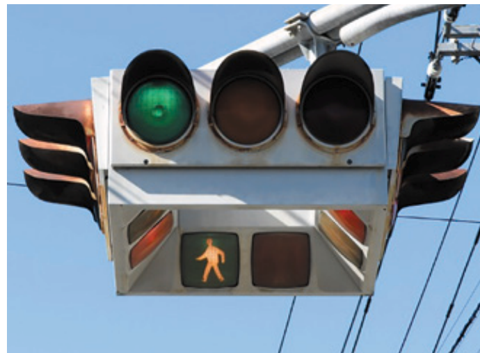
▲宮城県仙台市にある歩行者用と車両用の信号機が一体となった信号機(岩原撮影)
