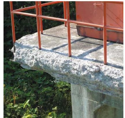
図1 凍害が生じたコンクリート構造物(寒地土木研究所提供)
