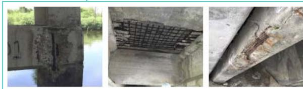
図1 タイ(左)、ミャンマー(中)及びタジキスタン(右)のコンクリート構造物の劣化事例
