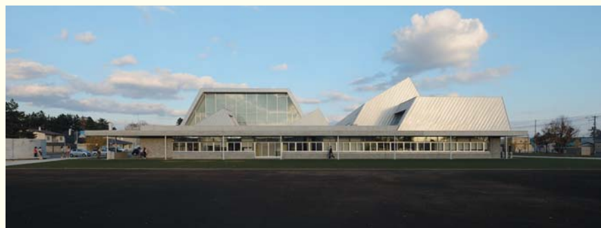
▲担当した小学校のグラウンド側から見た全景
