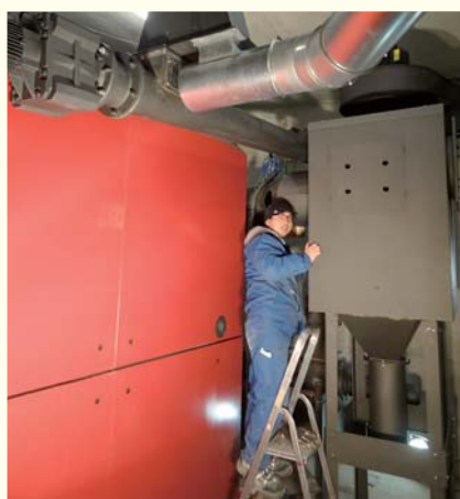
▲ボイラー据え付け作業
