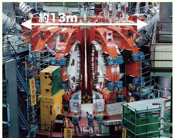
▲組み立て中のJT-60。オレンジ色の機器が真空容器の周りに設置されている電磁石コイル。手前に写っているのは作業中の人。
