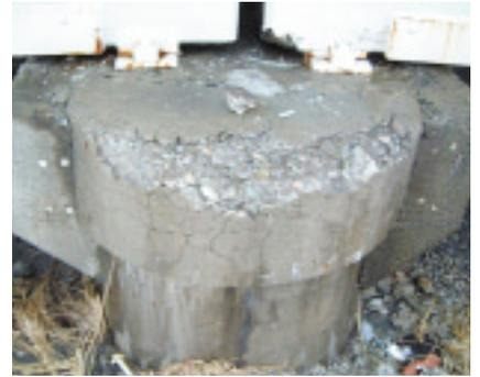
図1 コンクリート製橋脚の凍害
