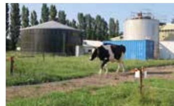
3 札幌第一農場(バイオガスプラント) 北方生物圏フィールド科学センターが管理運営する札幌第一農場では、牛のふん尿から生まれるバイオガスをエネルギーとして活用する研究が行われています。工学と農学が力を合わせ、環境やエネルギーの未来に挑む連携研究の場です。
