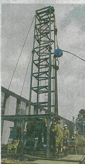
地中熱利用の実証試験のため、北大構内で行われた300メートルの深さにチューブを下ろす作業
