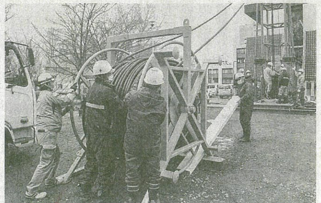
有我工業所のスタッフが長さ300mの採熱管を徐々に挿入していった
