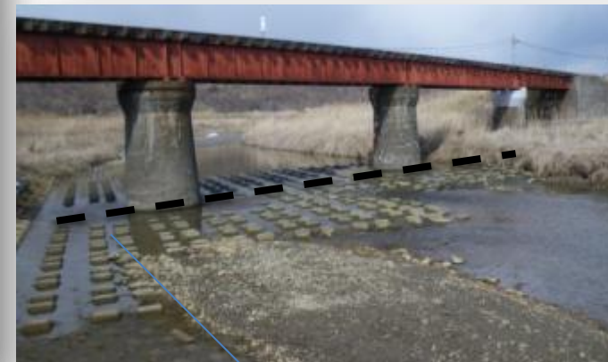
構造物(床止)による停止(布辻川)
