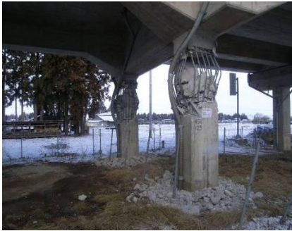
柱のせん断破壊
