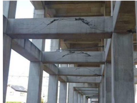
中層ばりのせん断破壊
