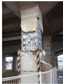
柱のせん断破壊
