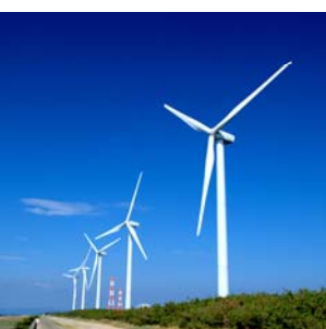
エネルギー関連施設
