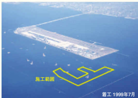
▲関西空港2期工事の写真(左:施工前、右:護岸完成時)
