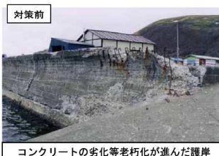
コンクリートの劣化等老朽化が進んだ護岸
