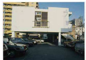
○洪水時に被害がないようピロティ構造を採用
