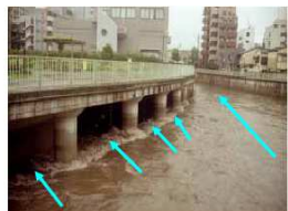
洪水調整施設の整備(地下調整地)
