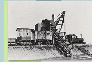
新水路掘削中の掘削機 （エキスカベーター）
