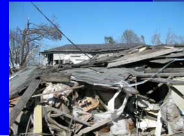
下第九地区の被害状況
