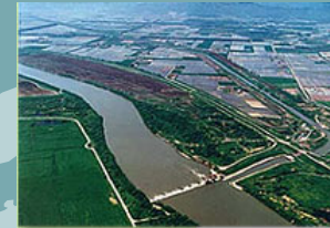
建設当時（昭和30年代）の石狩川頭首工と 篠津運河【石狩川】
