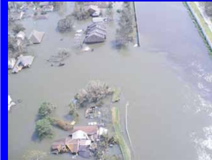
17番通り運河破堤状況
