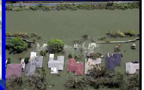
ロンドン通り運河北破堤現場
