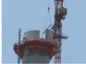
セグメントの設置
