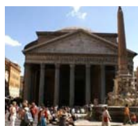
図1 パンテオン(ローマ) 約2000年前のコンクリート 構造物
