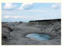
▲宮城県名取市北釜海岸 越流した津波により破壊された堤防
