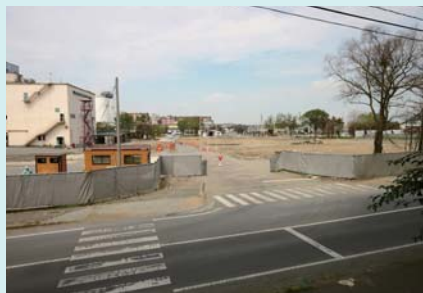
同 瓦礫処理後
