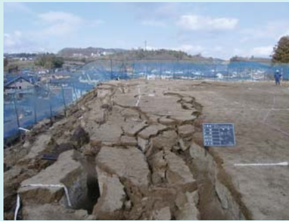
白石市内の中学校のグラウンドが崩落
