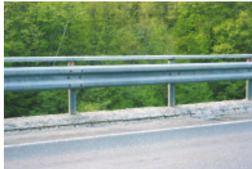
図1 スケーリングによる鉄筋の露出・腐食 (北海道内の山間部の橋梁)
