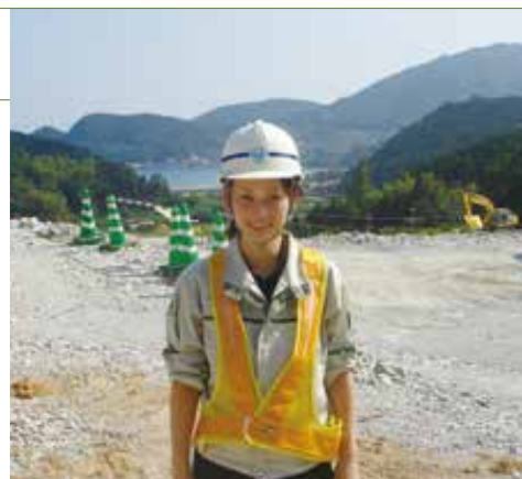
三重県の工事現場にて
