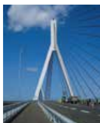
▲斜張橋の維持管理現場の視察
