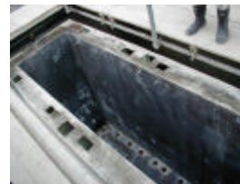
PCa mold preparation
